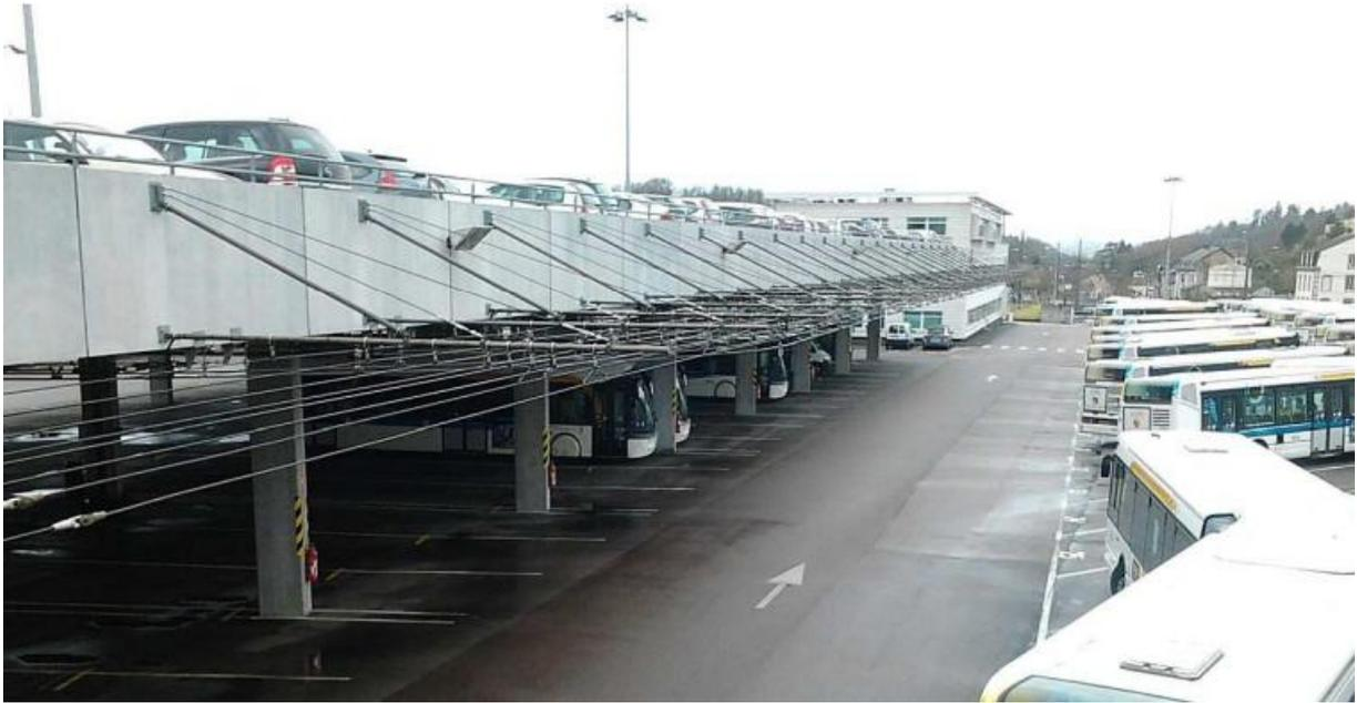
La gare de dépôt des trolleybus de Limoges reçoit sur sa toiture le parking du personnel. Ce bâtiment doit donc résister à la charge des véhicules en stationnement et aux charges exceptionnelles dues à la neige. Le bâtiment est composé d'une dalle en béton armé ( $25\text{kN/m}^3$ ) supportée par des poutres elles-mêmes soutenues par des poteaux, comme on peut le voir sur le modèle numérique simplifié ci-dessous.
